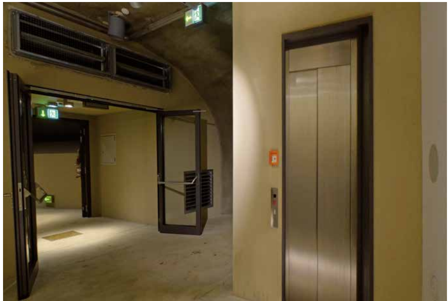
Bild 21: Aufzugsvorraum mit einer Schleuse
